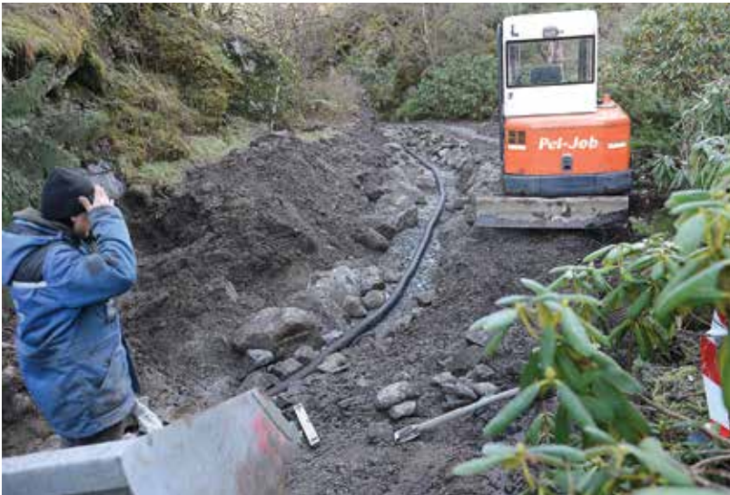
Ny drenering legges langs veien gjen- nom Tøm- mersmåget (foto: Bjørn Moe 18.02.2014)
