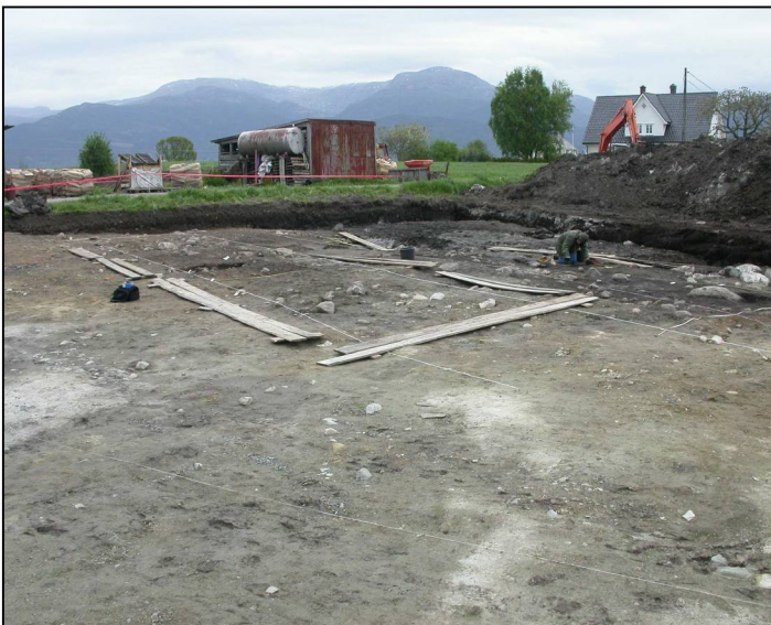
Figur .12. Situasjon ved graving. Mot NØ (Foto DSCN1476)
