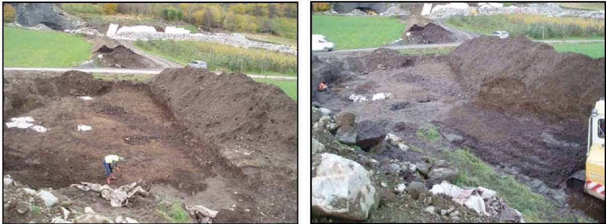
Figur 3. Grøft A-42 etter avdekking
