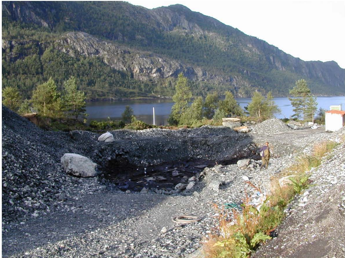
01 Felt set under udgravning imellem grusdækning
