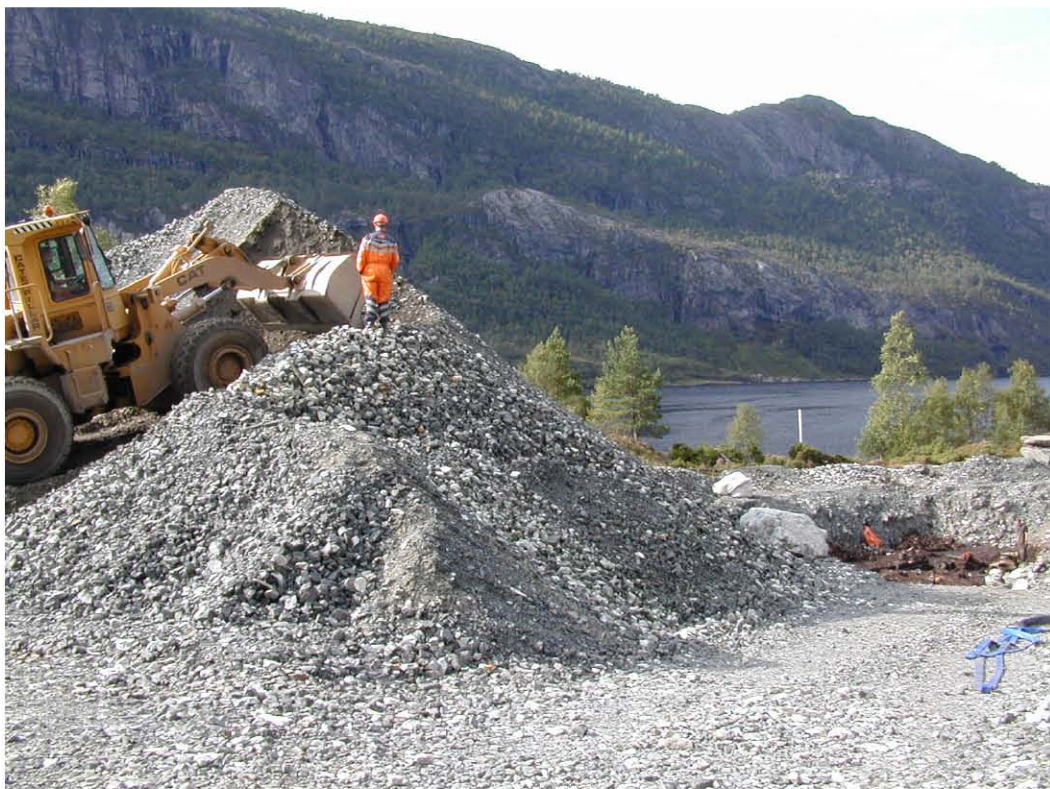
10 Felt set under udgravning imellem grusdækning
