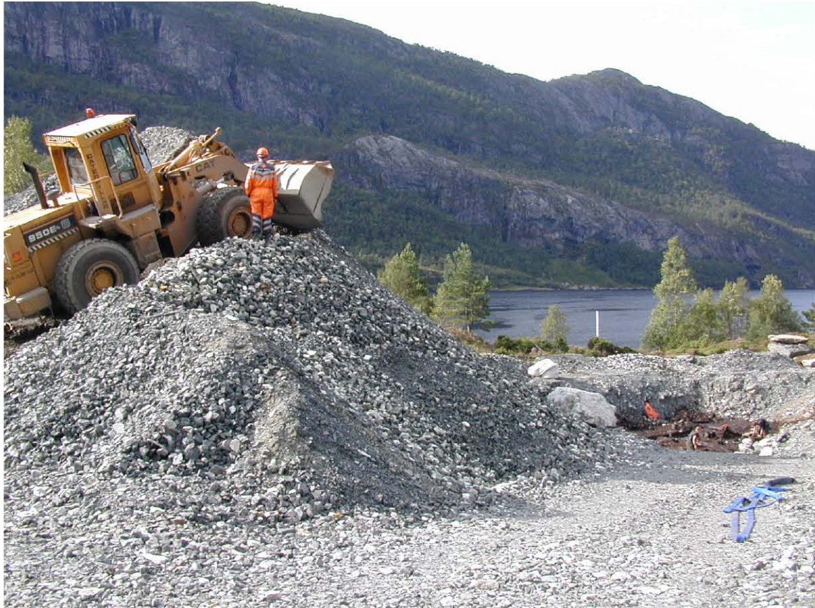
11 Felt set under udgravning imellem grusdækning
