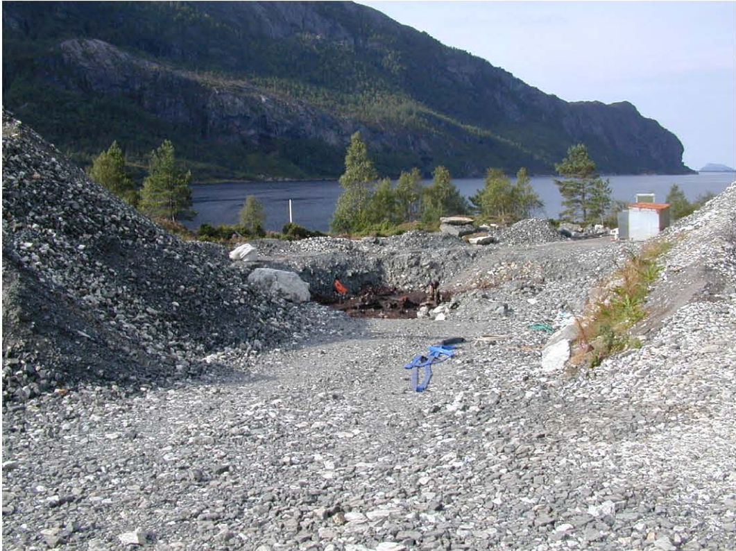
09 Felt set under udgravning imellem grusdækning
