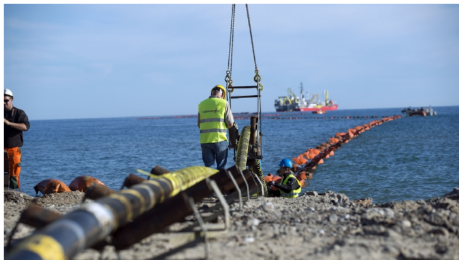
TJENER PENGER: Statnett har tjent nesten 3 milliarder kroner på strømkablene til Danmark og Nederland de siste fem årene, og rundt 674 millioner kroner er brukt på å redusere strømkundenes nettleie, opplyser nettoperatoren. Dette er fra leggingen av Skagerak 4, den fjerde strømkabelen mellom Norge og Danmark, som ble satt i drift i 2014.
