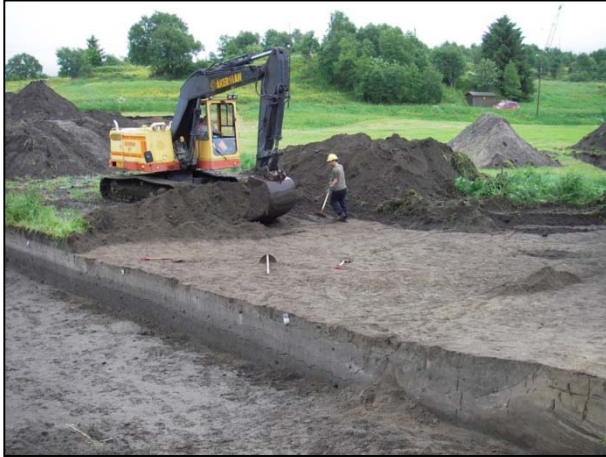
Figur 51. På foto er Thorbjørn Schou i gang med at afdække toppen af lag 5 i fase i fase B. Først blev den dækkende fyld aførømmet med gravemaskine og derefter oprenset manuelt. Foto S. Diinhoff.
