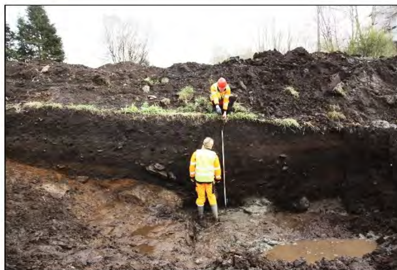
d) Dyrkningprofil 1, før kollaps.
