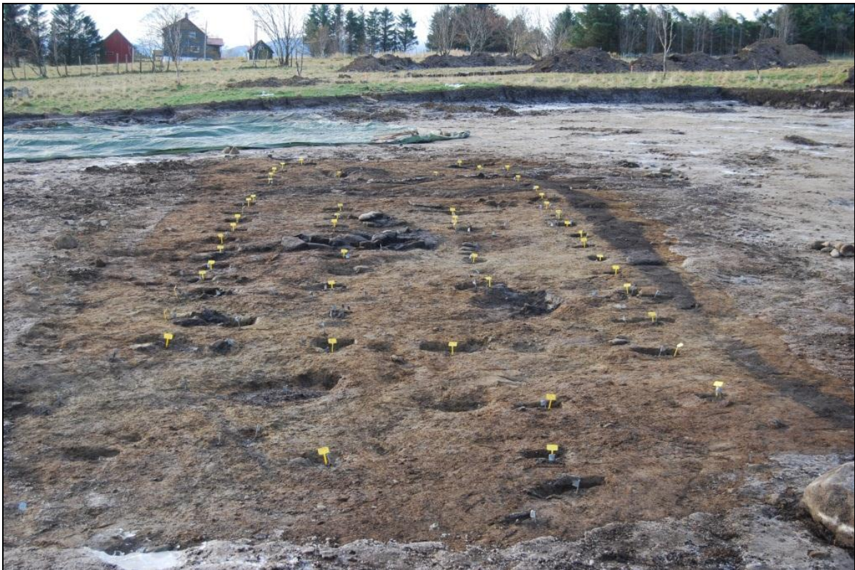
Fig.12. Hus A med dreneringsgrøft. Sett mot SV (foto F. Aanderaa).
