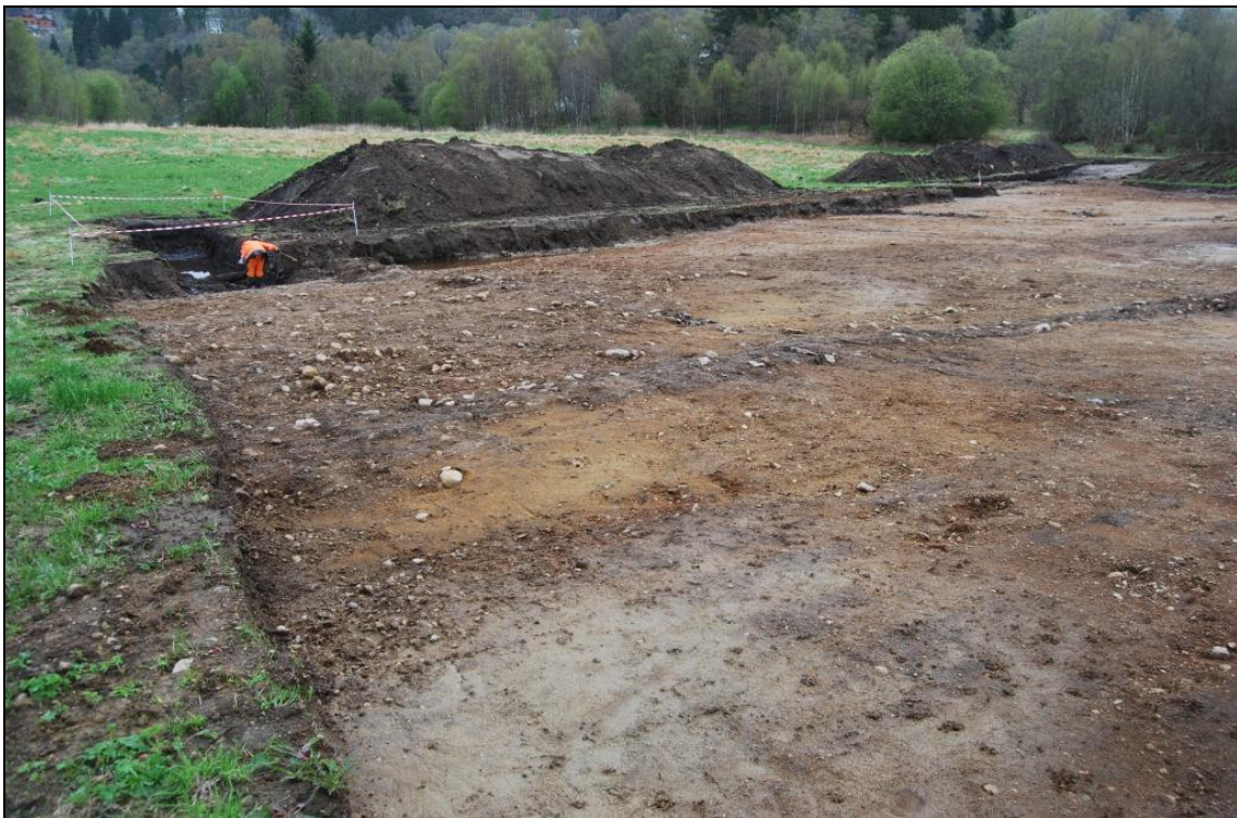
Fig.6. Oversikt over feltet etter avdekking, sett mot NØ (foto F. AA).
