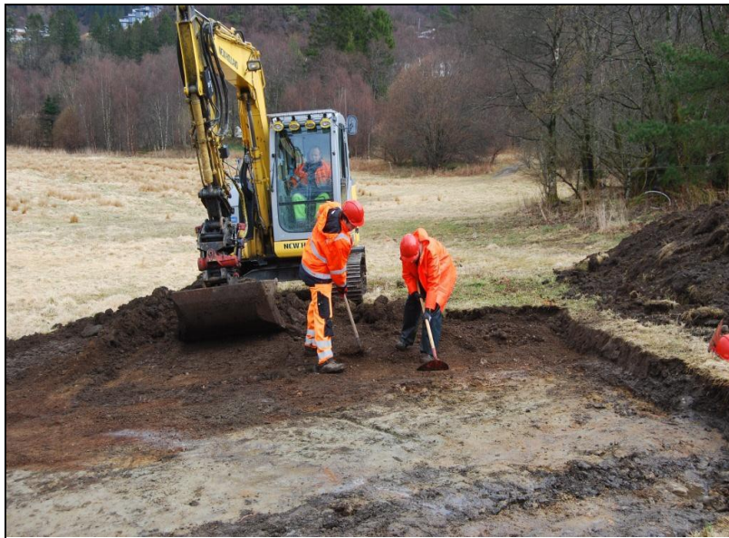
Fig.3. Flateavdekking med maskin (foto F. AA).
