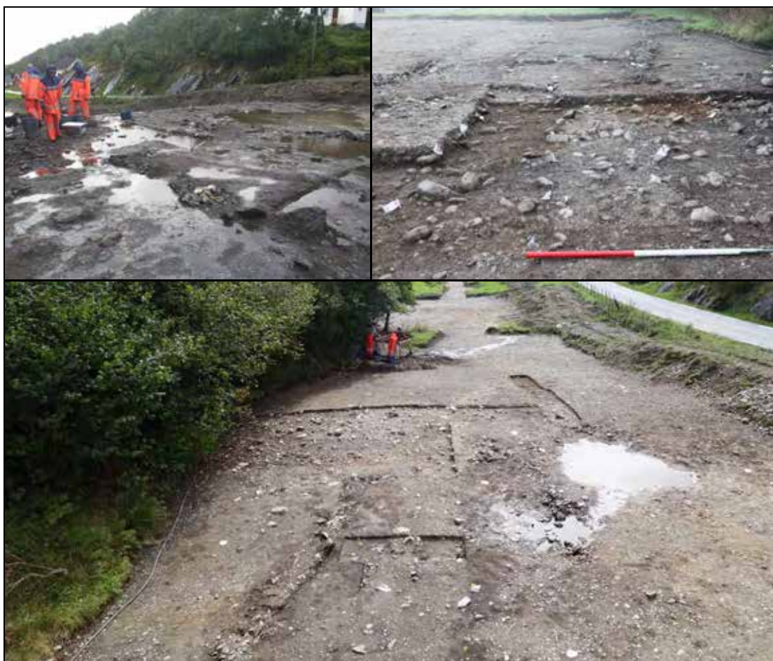
Fig 11. Situasjonen på Lok 1 etter regnvær. Nyere tids forstyrrelser i undergrunnen ses i forkant på det nedre bildet. Bilde øverst til venstre er tatt mot SV, til høyre mot NNØ, bilde underst et tatt mot SSV (Foto: FMS).
