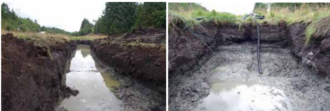
Fig 44. Sjakt I. Bildet viser vannsituasjonen i sjakta. Lensepumpe plassert lengst nord. De kraftige skjellavsetningene nederst i bilde til høyre («pumpehullet»). Mot nord (Foto: FMS)
