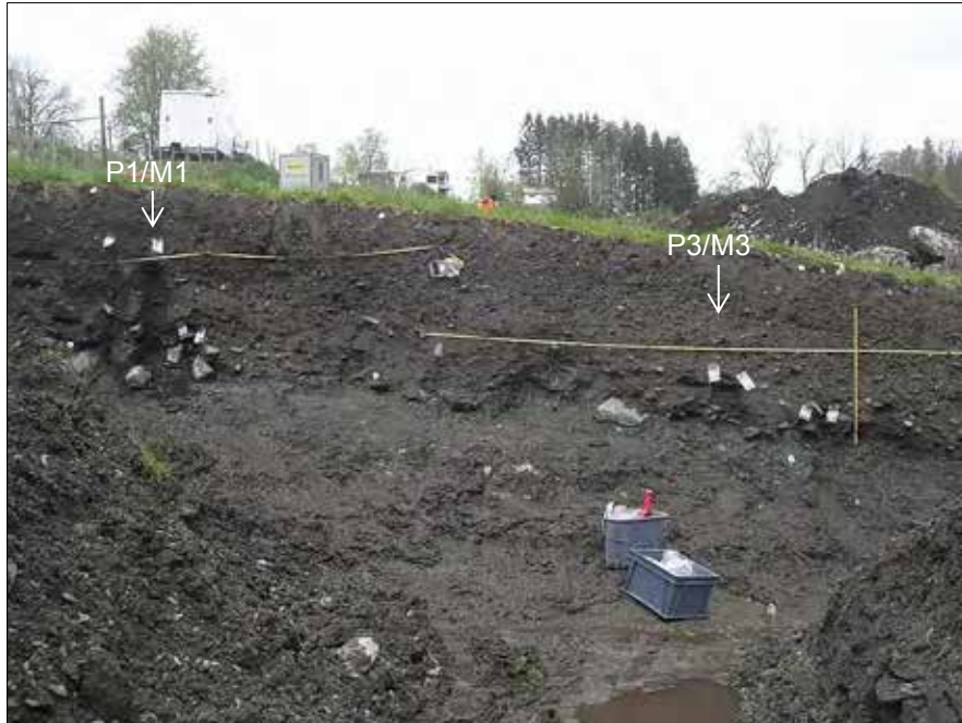
Fig. 4: Sjakt 1 med fire pollen- og makrofossilprøveserier, der prøver fra P1/M1 og P3/M3 ble analysert.
