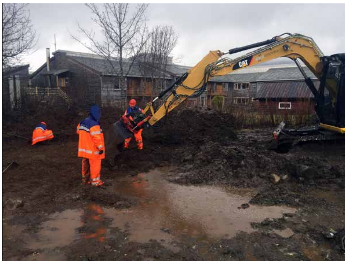
Figur 4. Arbeidsbilde avdekking id 215887.
