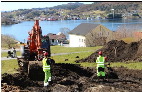
Figur 6. Avdekking med maskin, sett mot SV.
