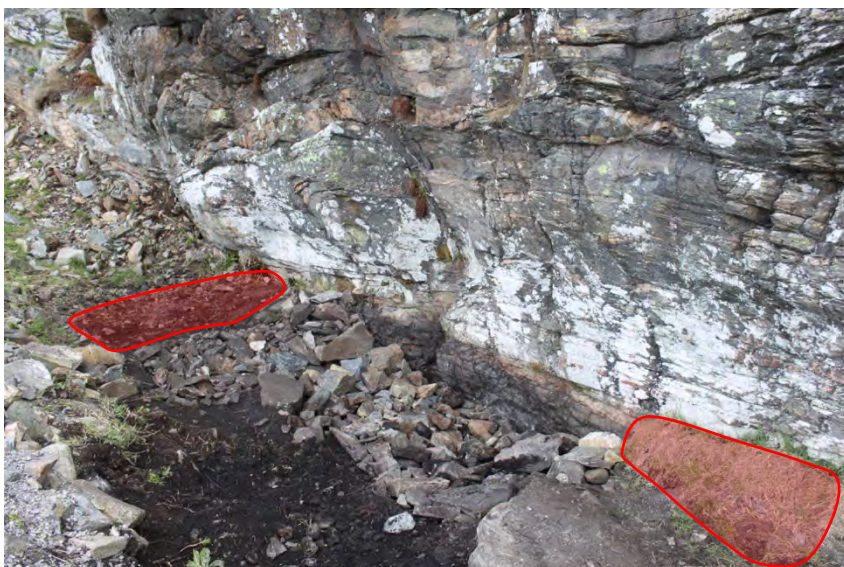
Figur 24. Etter endt undersøkelse ble hele feltet fylt med stein, sett mot nord, nordvest. Det ble særlig lagt vekt på å stabilisere profilen mot de intakte hellermasser innenfor profilen mot nordvest og i forkant mot sør (merket rødt på foto).
