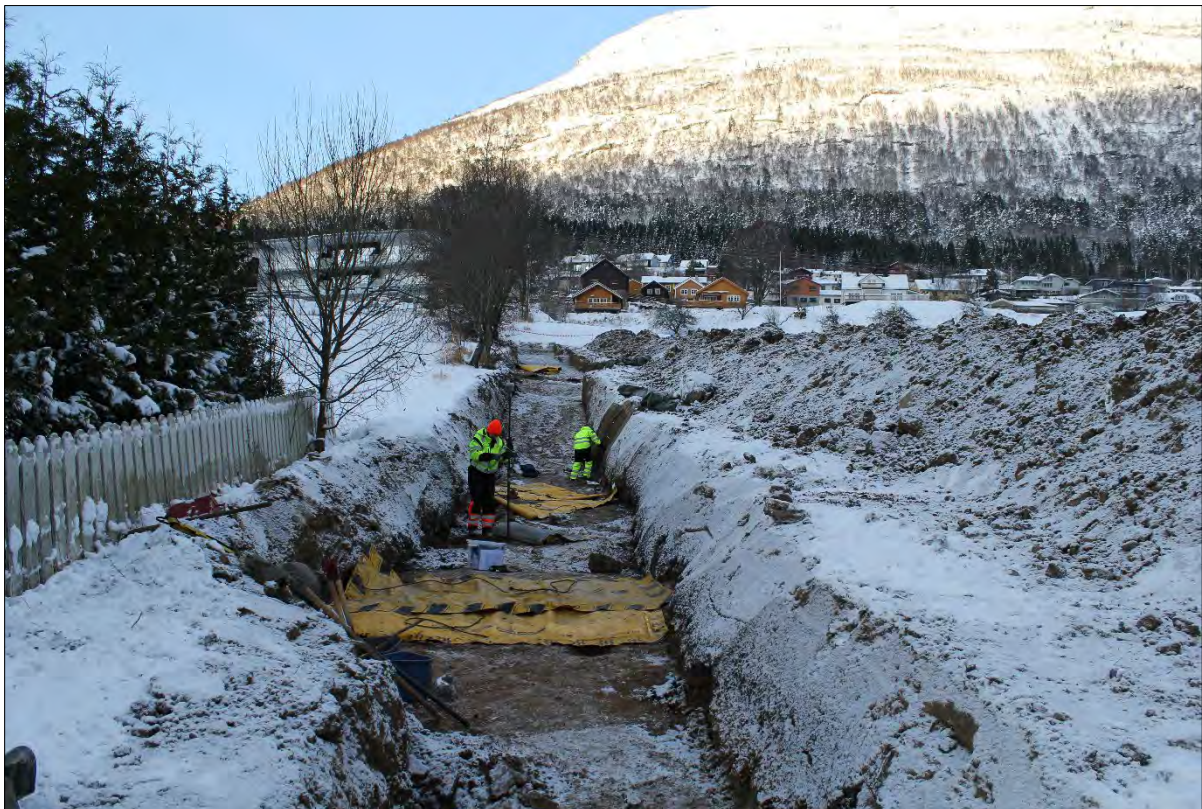
Figur 5. Undersøkellesområdet, Hanne Årskog måler inn strukturer og Anette Overland dokumenterer dyrkningsprofil 1. Isolasjonsmattene var nødvendige for å klare å rense opp og snitte strukturene som frøs til i 13 minusgrader. Sett mot nord.
