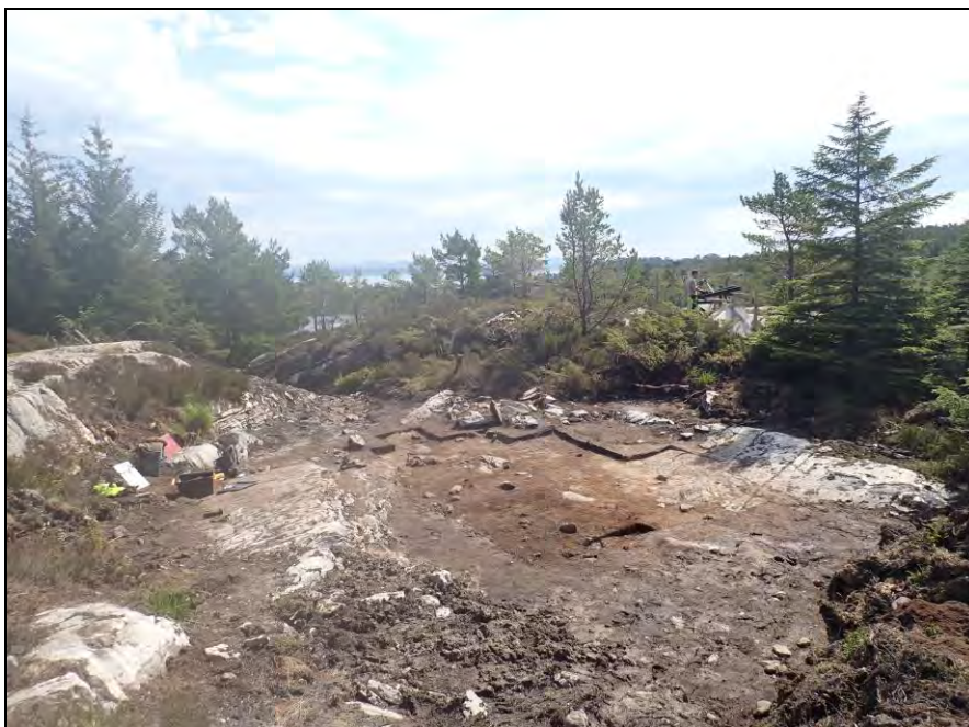
Figur 14. Arbeidsfoto fra Lokalitet 2. Foto: Fredrik Solli, sett mot sørøst.
