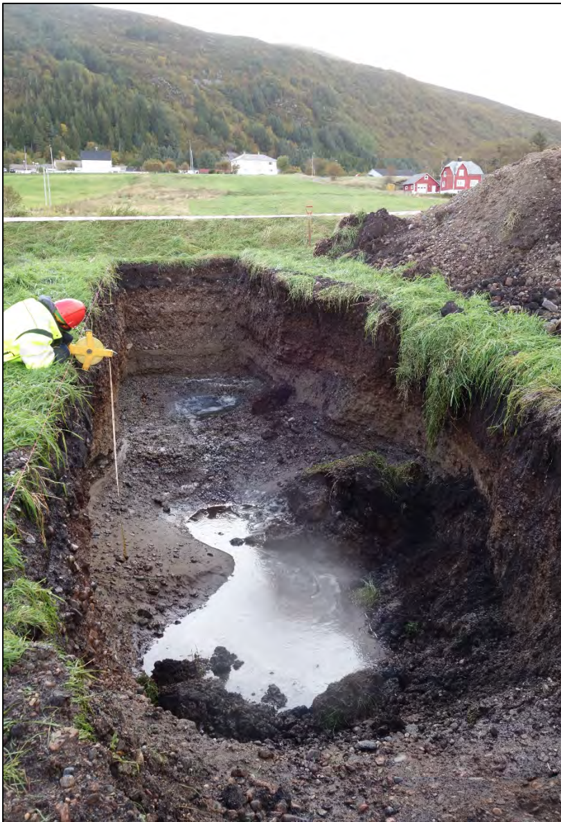
Figur 14 Foto av sjakt 2.
