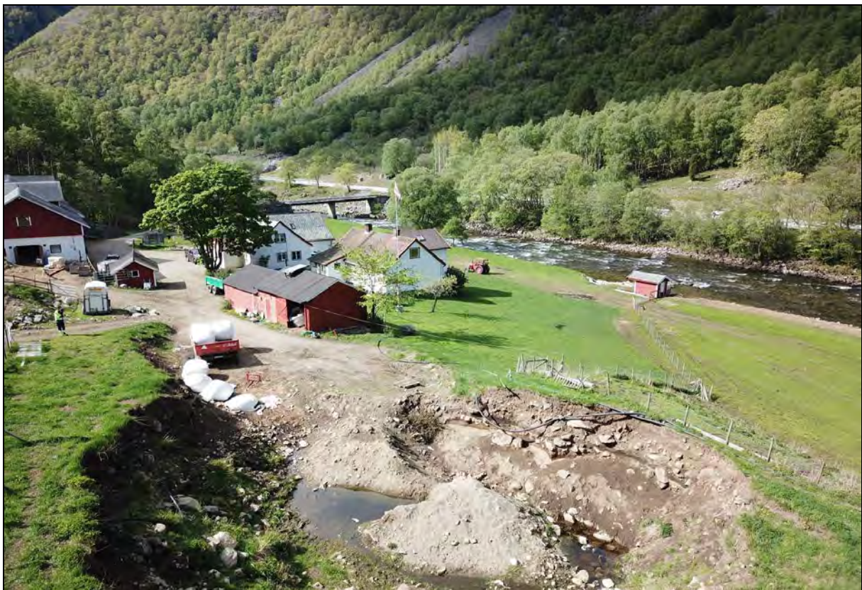
Figur 9 Lokaltet id 248367 ved driftsbygningene var et krater gravd ned gjennom dyrkning og utallige raslag.
