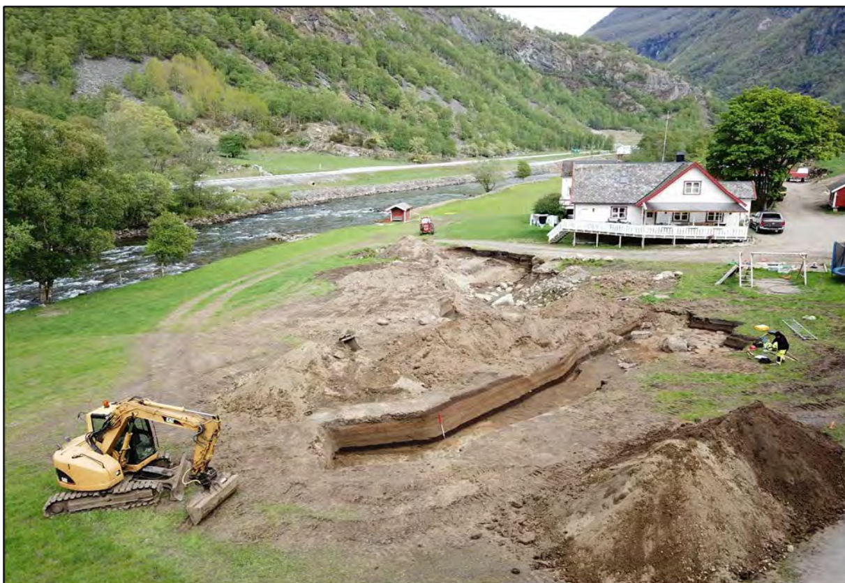
Figur 11 Tunet og id 248364, sjakten synlig i forkant.
