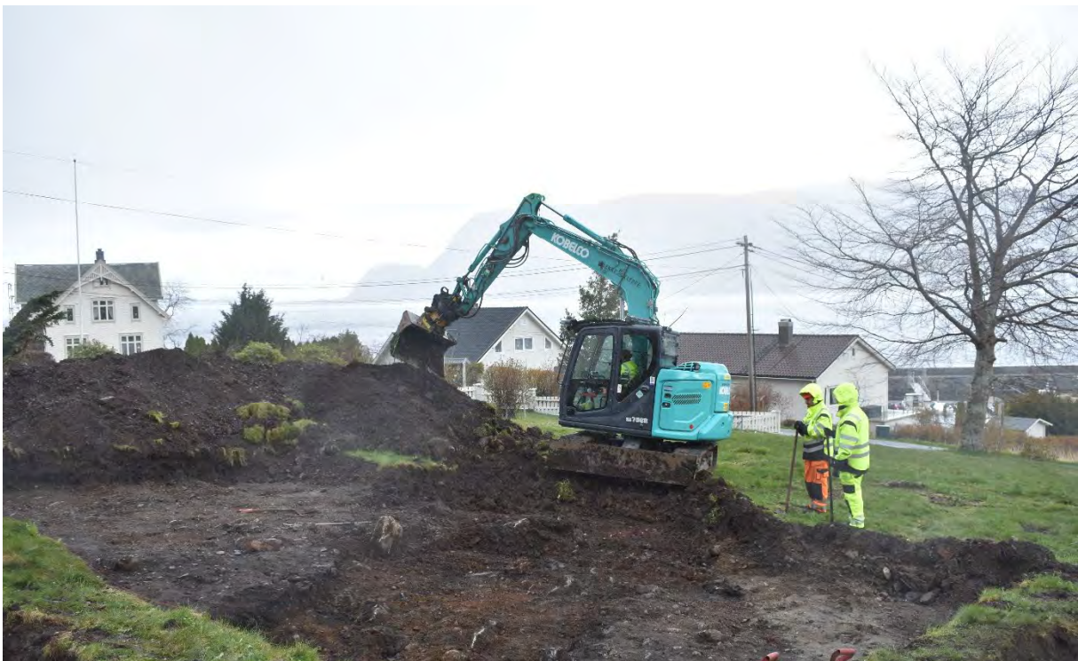
Figur 9 Maskinell avtorving sett mot nordøst.
