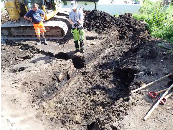
Figur 11- Innmåling av tverrgående sjakt.
