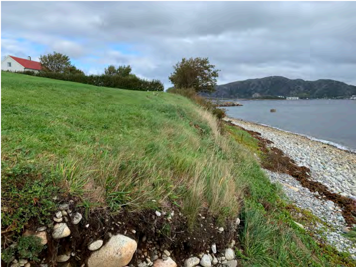
Figur 11 Fenomenet med knekk i landskapet ved kanten er observert på plenen til næraste nabo sørvest for undersøkningsområdet. Dette er om lag 30 meter SV for struktur 43/44. Foto mot NA.
