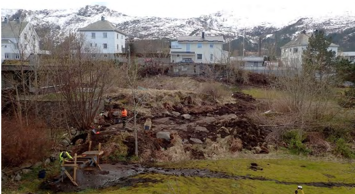
Figur 3 Oversiktsbilde av lokaliteten sett fra nord.
