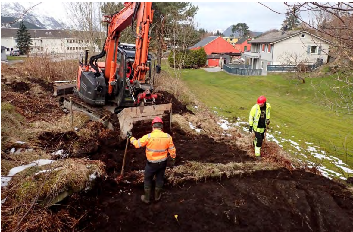
Figur 9 Maskinell avdekking.
