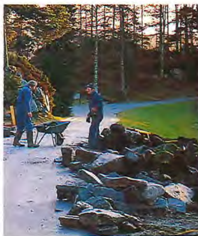
Mye stein gikk med for å lage muren ved Blondehuset (foto Steinar Handeland).
