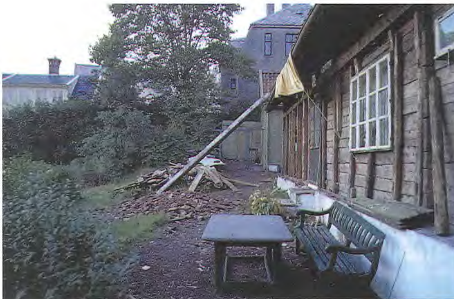
Denne og motsstående side: Forgjengeren til pakterboligen: en værslitt, laftet bygning i hugget tømmer ser dagens lys etter minst 110 år bak Blondehusets panel. Benken og steinbordet står fortsatt som det gjorde i 1866. Det er som om urnene med bladtiljer ved trappen har stått der like lenge (foto Ove Kobbeltvedt, september-oktober 1973).
