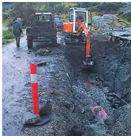
Grøft for fundament til muren ved Blondehuset graves (foto Per H. Salvesen).
