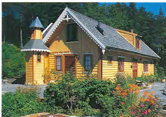
Blondehuset 1999, nyoppusset og med ny hage, klart for nytt århundre (foto forfatteren).
