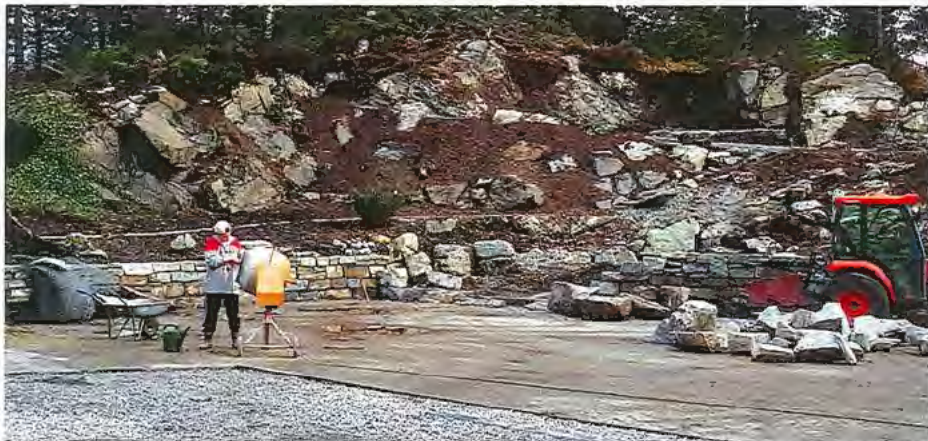
Ny parkeringsplass ved garasjen (foto: forf.).
