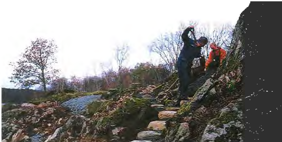
Jon Inge Kleveland og Solveig Mette Tjeltveit legger trappetrinn i Fjellhagen (foto: forf.).
