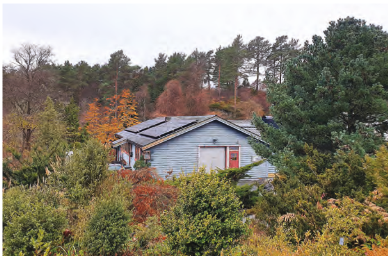
Driftsbygningen i Arboretet har fått solcellepanel på taket (foto: Michael David Pirie 15. november 2023).
