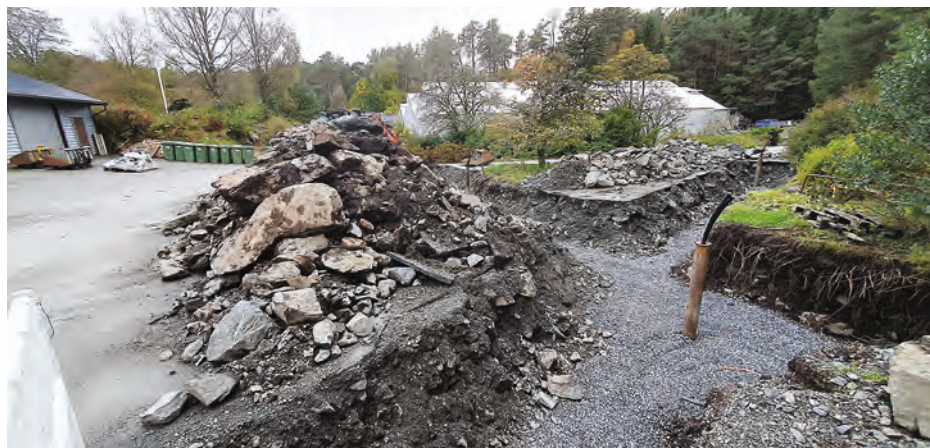
En periode var det ganske uframkommelig i driftsområdet i Arboretet på Milde mens rørforbindelsene til bergvarmeanlegget ble lagt i lange grøfter (foto: Terhi Pousi, 1. oktober 2023).
