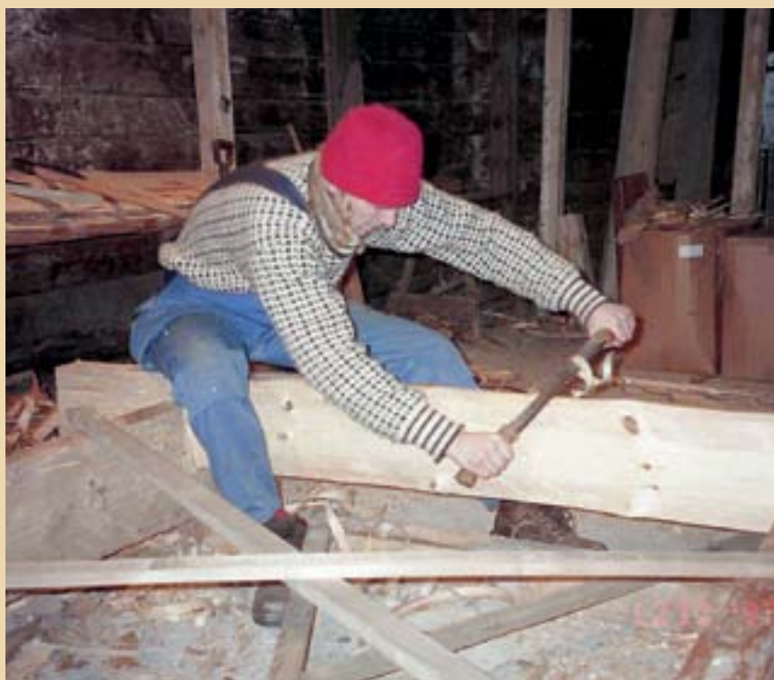
■ Figur 5. Håndverkere utfører istandsettingsarbeidet etter gamle håndverksteknikker og ved hjelp av kopier av gamle redskaper. Foto: Stiftelsen Bryggen
