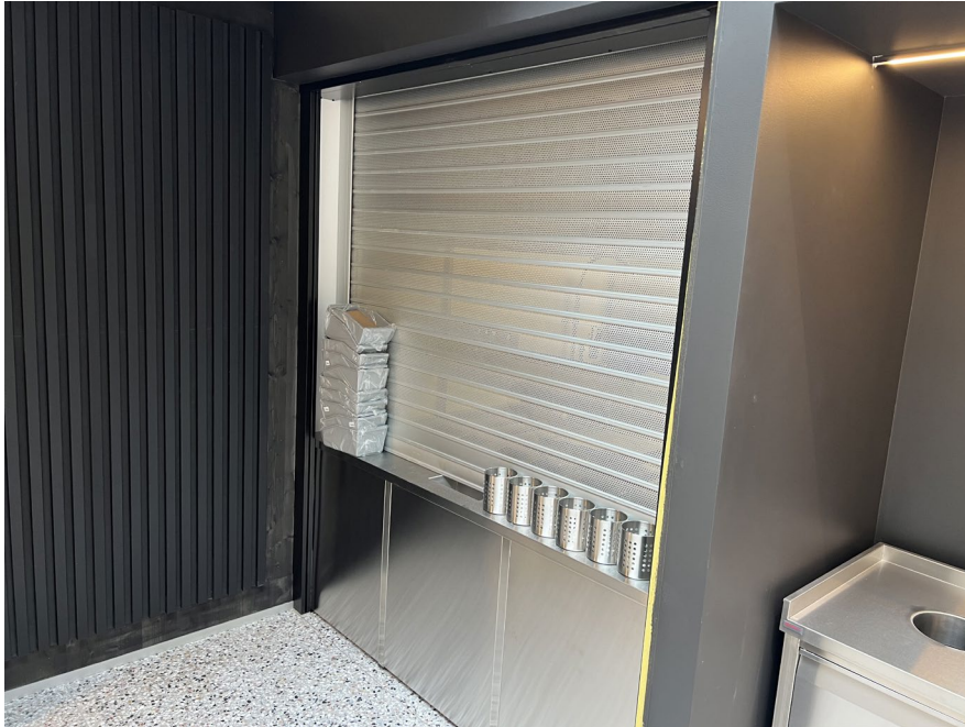
Figur 19 Hindring i sporet til branngardin
