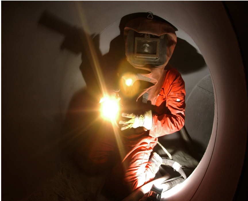
Figur 6.8. Arbeidet foregår ikke alltid i store rom, men kan forekomme i trange rørgater, slik som her. Selv under trange forhold, skal verneutstyr benyttes.
