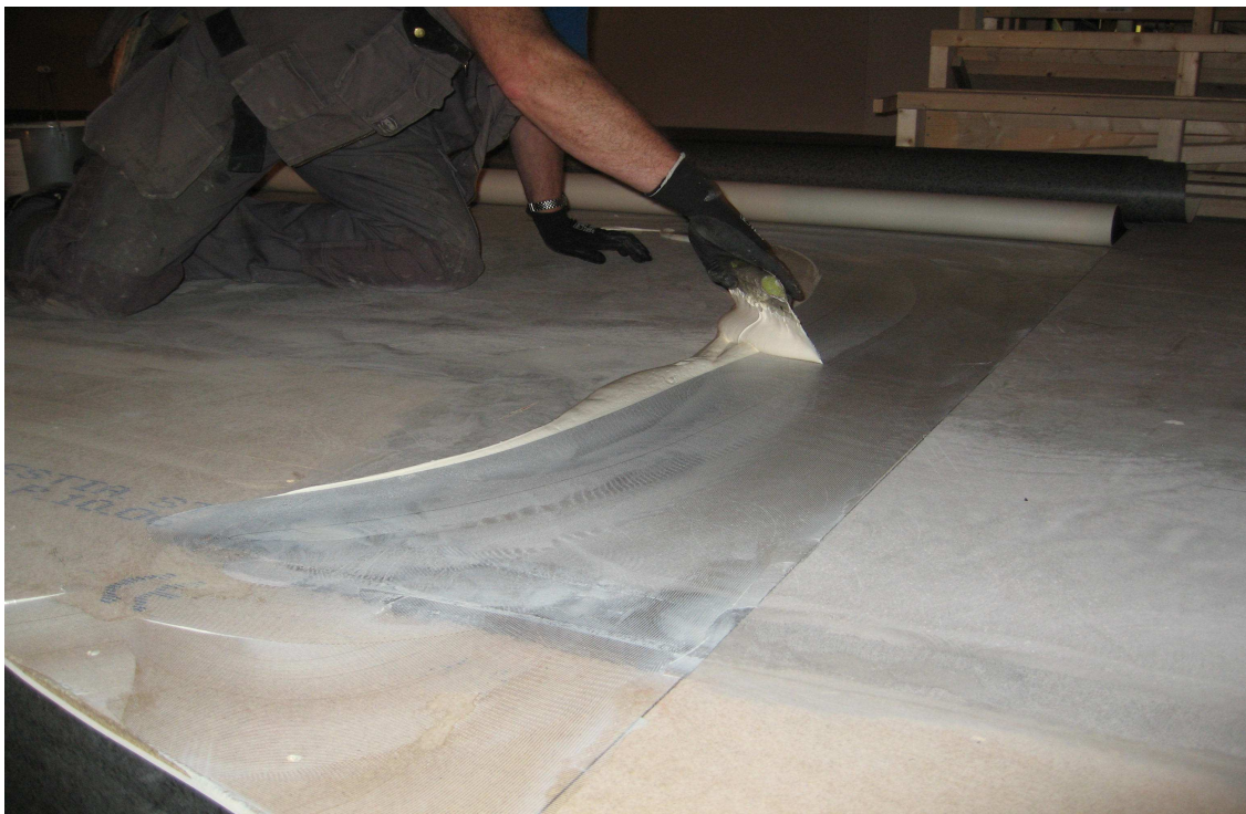
Figur 7.5. Lim under gulvbelegget legges på i store flater. Det gjelder å ikke få søl på huden.
