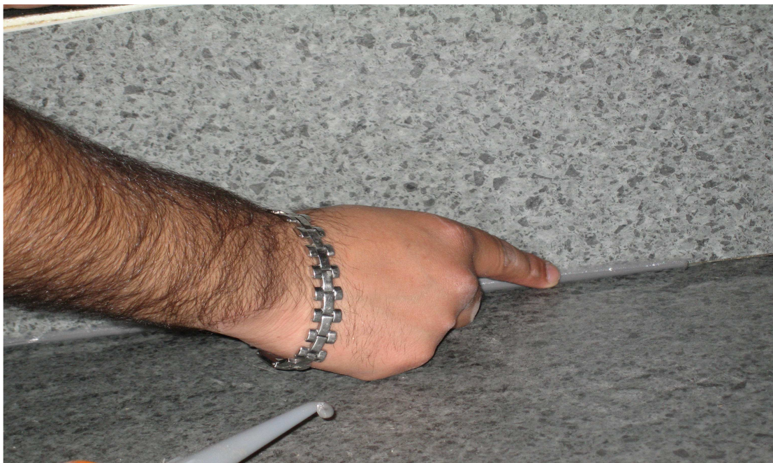
Figur 7.7. Det er fort gjort å stikke fingrene borti limet for å "jevne" på kanter og lignende. Dette er svært uheldig – huden utsettes for de kjemiske stoffene, og risikoen for håndeksem øker. Rett verktøy er påkrevet under slikt arbeid.
