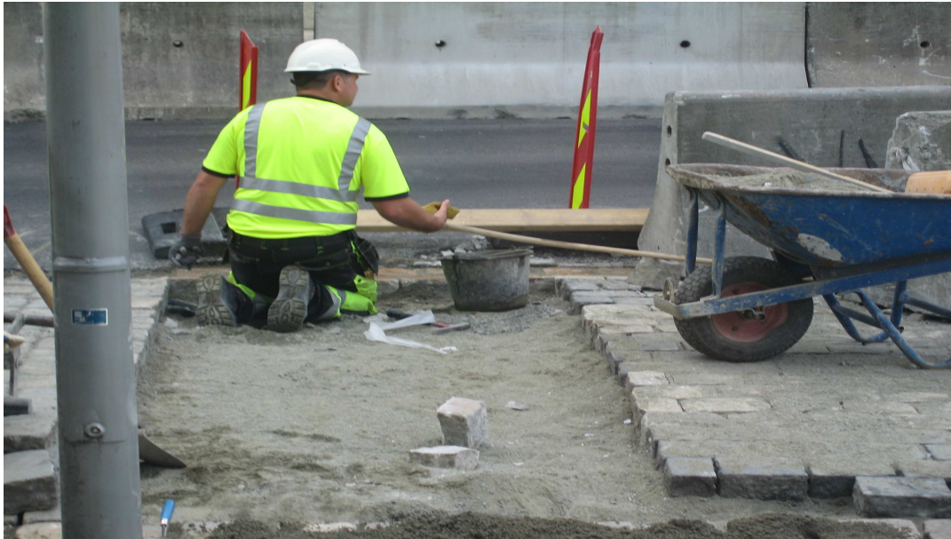
Figur 7.8. Brostenslegging er en kunst, og gir kontakt med sement, sand og vann. Her har brostensleggeren ingen hansker, og håndterer en fuktig svamp. Dette er ikke heldig for huden på hendene!
