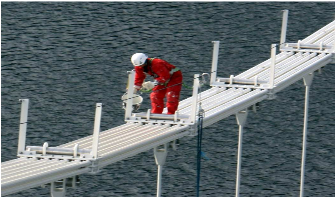
Figur 6.10. Selv på meget utsatte arbeidsplasser, som under maling av et brospenn, skal verneutstyr benyttes. Det er litt vanskelig å se, men maleren her er faktisk korrekt antrukket med åndedrettsvern, hansker og kjeledress. I tillegg er hun selvfølgelig sikret med sele og bruker hjelm.
