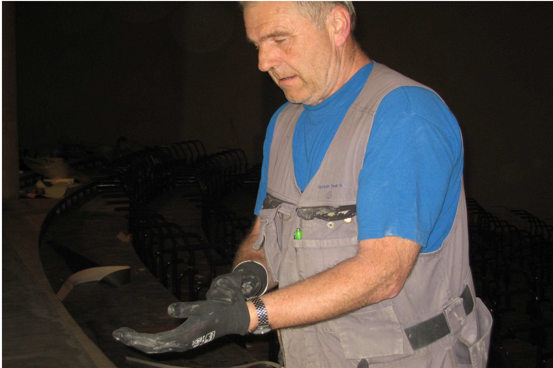
Figur 7.4. Gulvleggere bruker hansker for å beskytte hendene mot lim.
