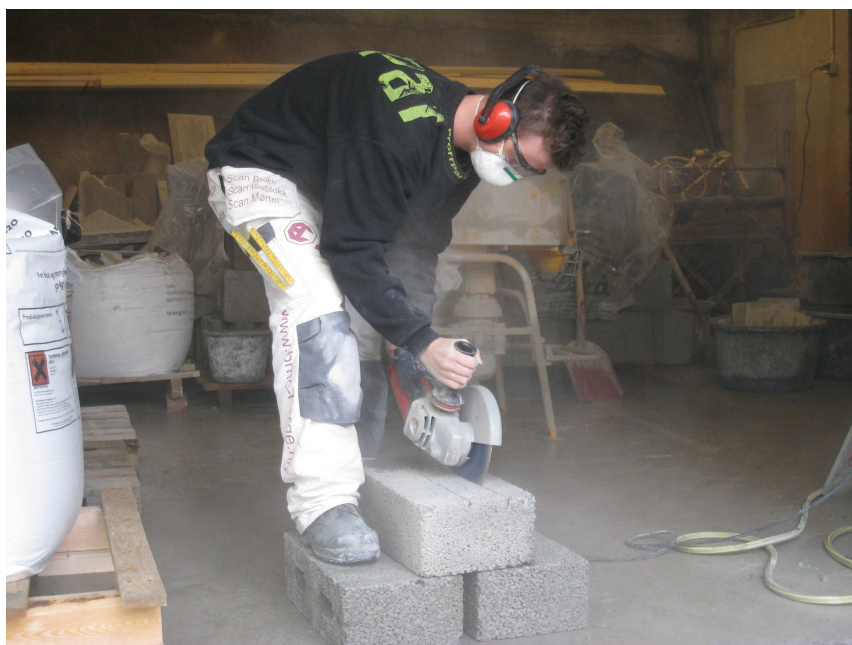
Figur 6.11. Det kan støve mye når man skjærer leca-blokker. Da skal åndedrettsvern brukes for å beskytte luftveiene (og øreklukkene beskytter mot støyen).
