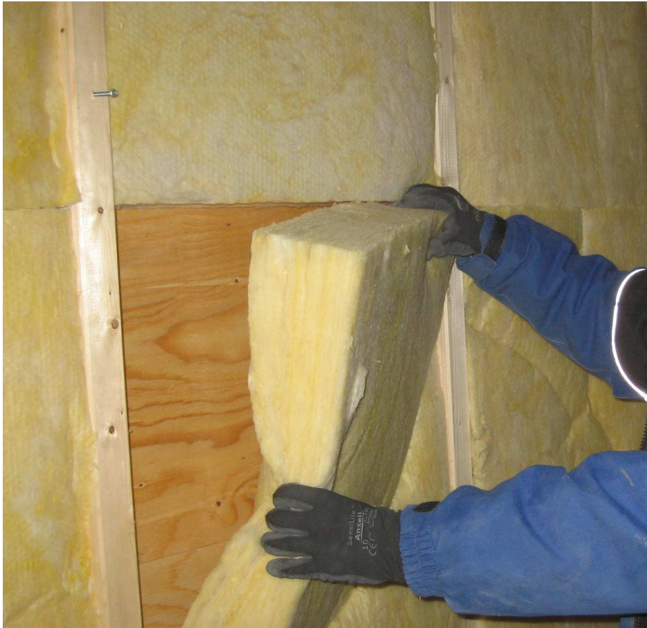
Figur 7.1. Det er klokt å bruke hansker når man håndterer isolasjonsmateriale, da denne kan inneholde irriterende fibre som kan skade huden. Også støvmaske bør benyttes.
