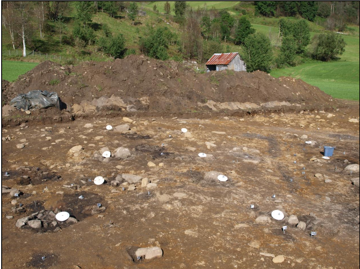
Figur 35: Oversiktsbilde av Hus J, med hvite papptallerkener på primærstolpene. Foto av A. B. Olsen
