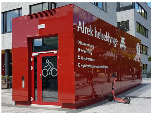
Sykkelgarasjen i sydenden av Alrek-bygget
