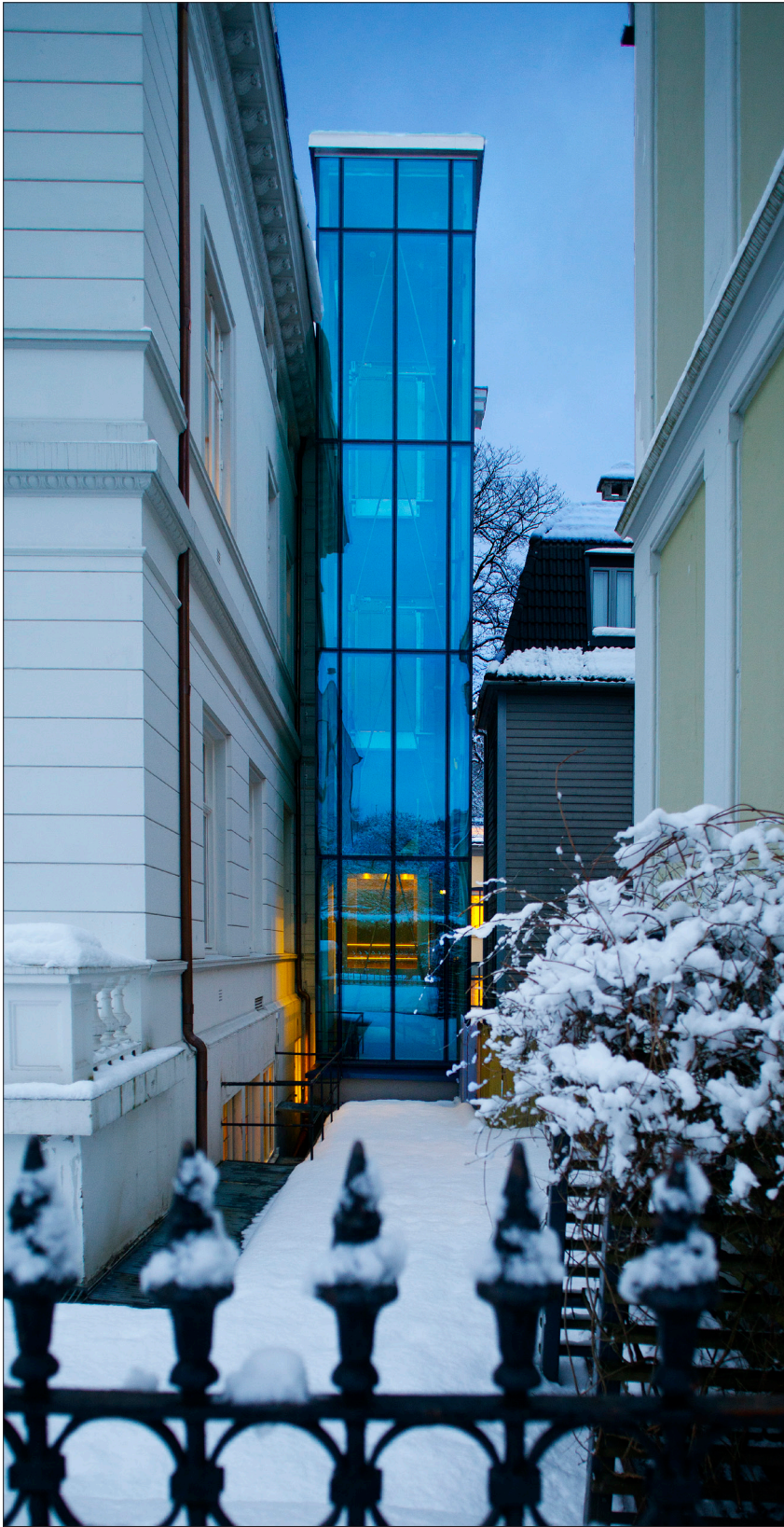
NY I DET GAMLE: Den nye heisen er kopla på den gamle murbygningen mot sør. b+b arkitekter ville unngå omfattande inngrep i den fredsfasaden.
